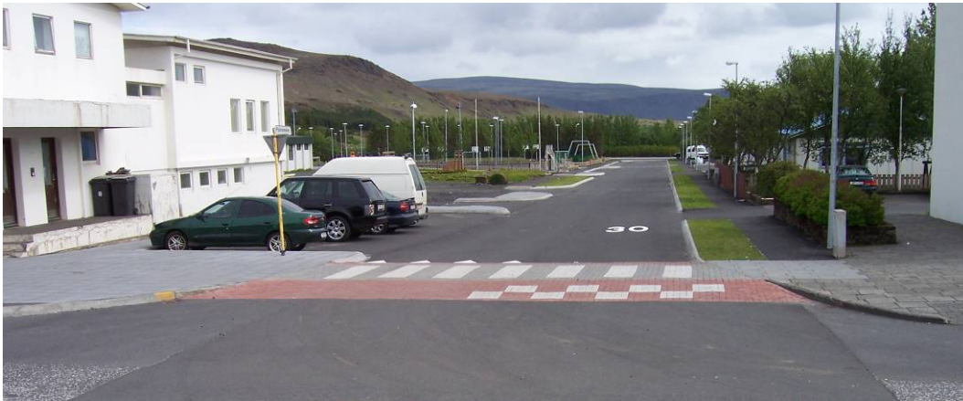
Mynd 9 Dæmi um 30km hlið við Fljótsmörk og sést að hámarkshraði er málaður á götu. Hér vantar gátstaura og skilti fyrir 30km hámarkshraða.
